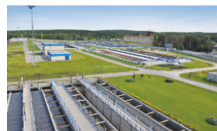
► Северная аэрационная станция
