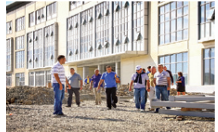
▶ А. Агаларов со строителями на стройплощадке
