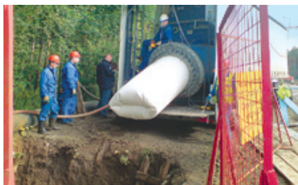
► Бестраншейная перекладка трубопровода
